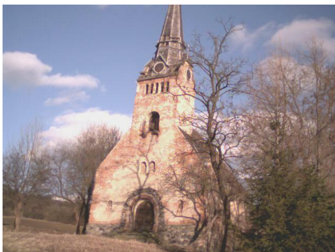
kostel před rekonstrukcí
