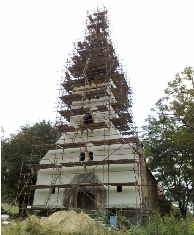
kostel při rekonstrukci
